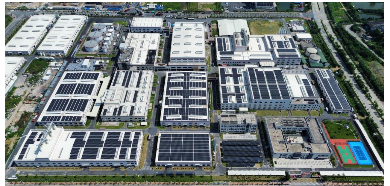
广州智都新能源屋顶分布式光伏项目
